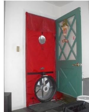
Figur 2.7. En så kallad "blower door". Notera fläkten i underkant (Expert-air, 2009).
